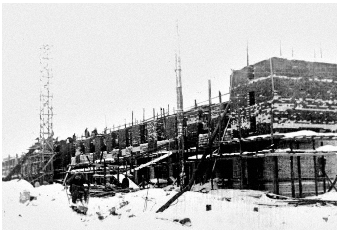
Строительство главного корпуса. 1938 год
